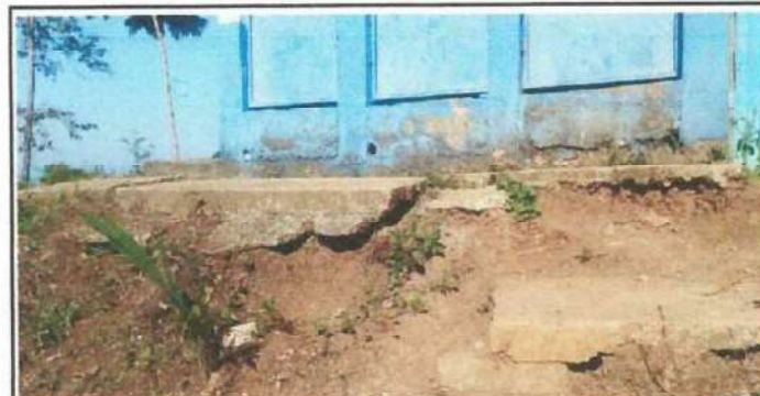
Foto 4: REHABILITACION BANQUETA BAÑOS
