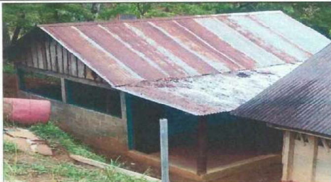
Foto 2: SUSTITUCION DE LÁMINAS , CAPOTES Y COSTANERAS METAL
