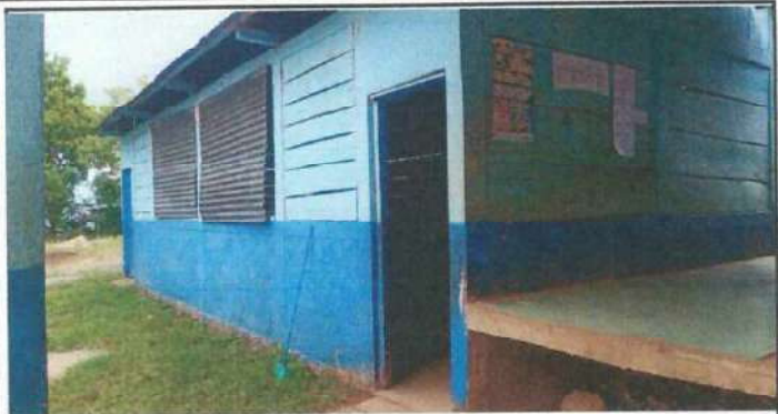
Foto1: SUSTITUCION DE VENTANAS, CERRAMIENTO CELOSIA, REPELO MURO
