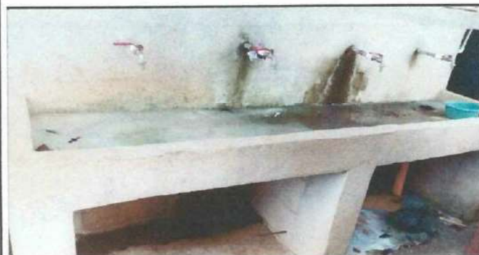
Foto 3: INSTALACION DE LOSA Y PISO CERAMICO, REPARACION.
