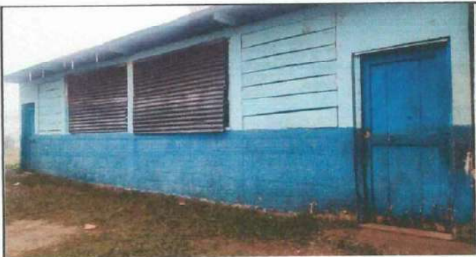
Foto 3: SUSTITUCION DE PUERTA 2 DE MADERA A METAL
