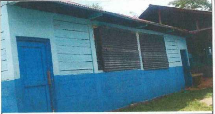
Foto 2: SUSTITUCION DE PUERTA 1 DE MADERA A METAL
