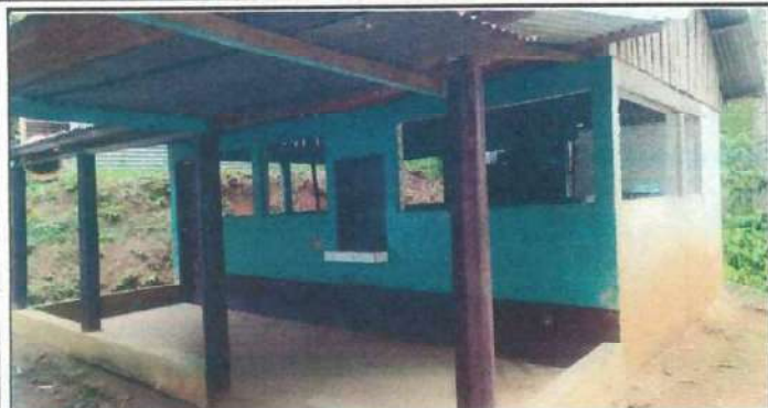
Foto1: SUSTITUCIÓN DE VENTANAS, PUERTA Y CERRAMIENTO CON CELOSIA
