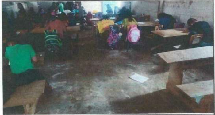
Foto 4: SUSTITUCION DE TORTA DE CEMENTO POR PISO CERAMICO
