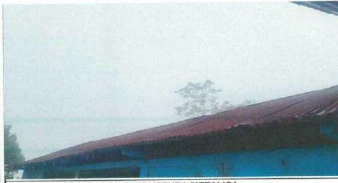
Foto 5: SUSTITUCION DE ESTRUCTURA METALICA
